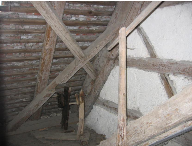
Dachstuhl Wohnhaus mit Andreaskreuzen
