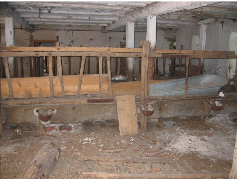
Stallgebäude mit Kappendecke
